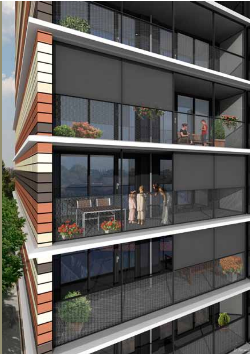
Ook voor de balkongevels van de middelhoogbouw luxe zonneschermen opgenomen in de balustrades
